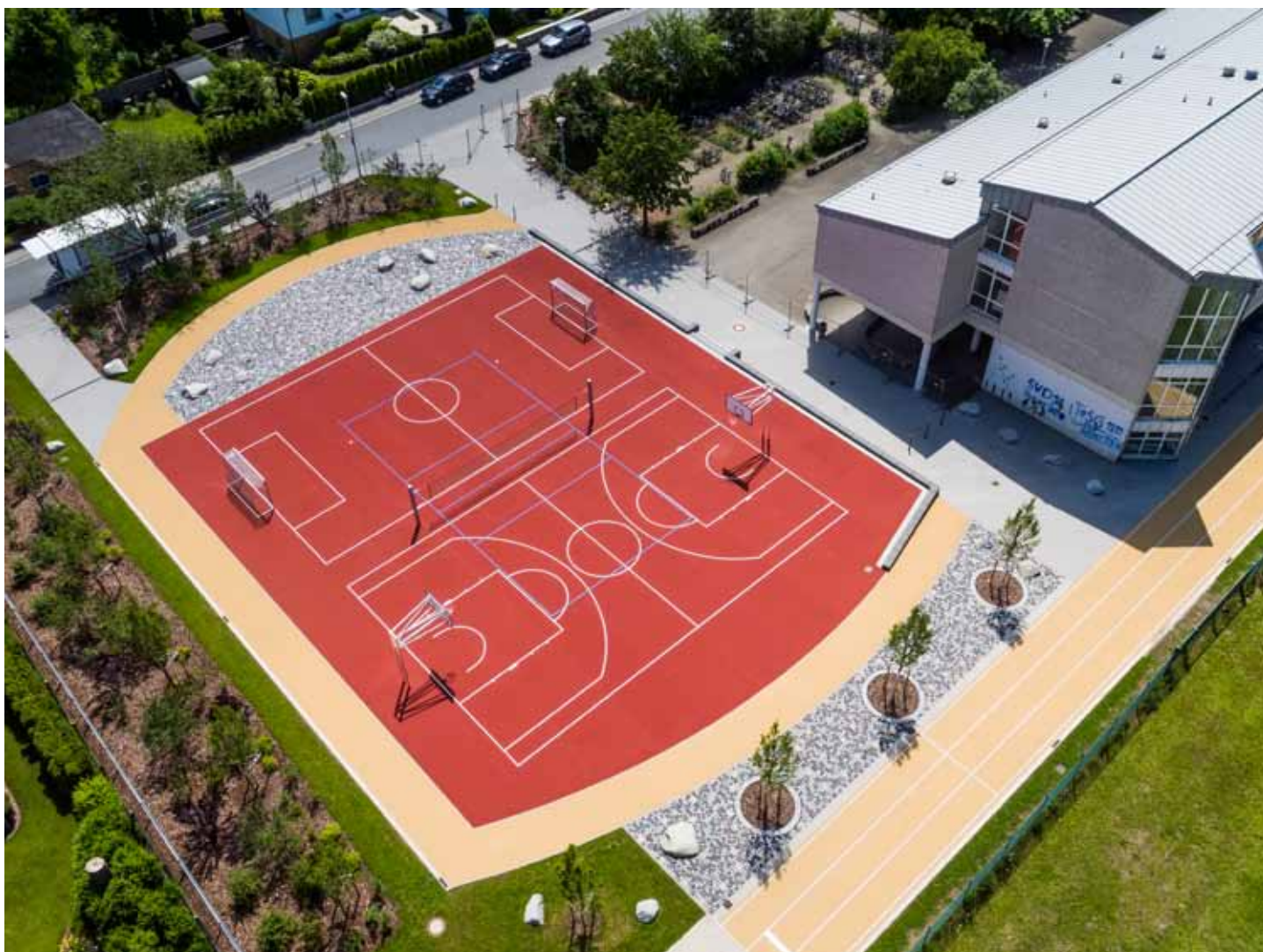
Die neue Bewegungsfläche an der Mittelstufe der Prälath-Diehl-Schule Groß-Gerau aus der Sicht einer Drohne. Foto: Dennis Möbus, Copternauten, GmbH
