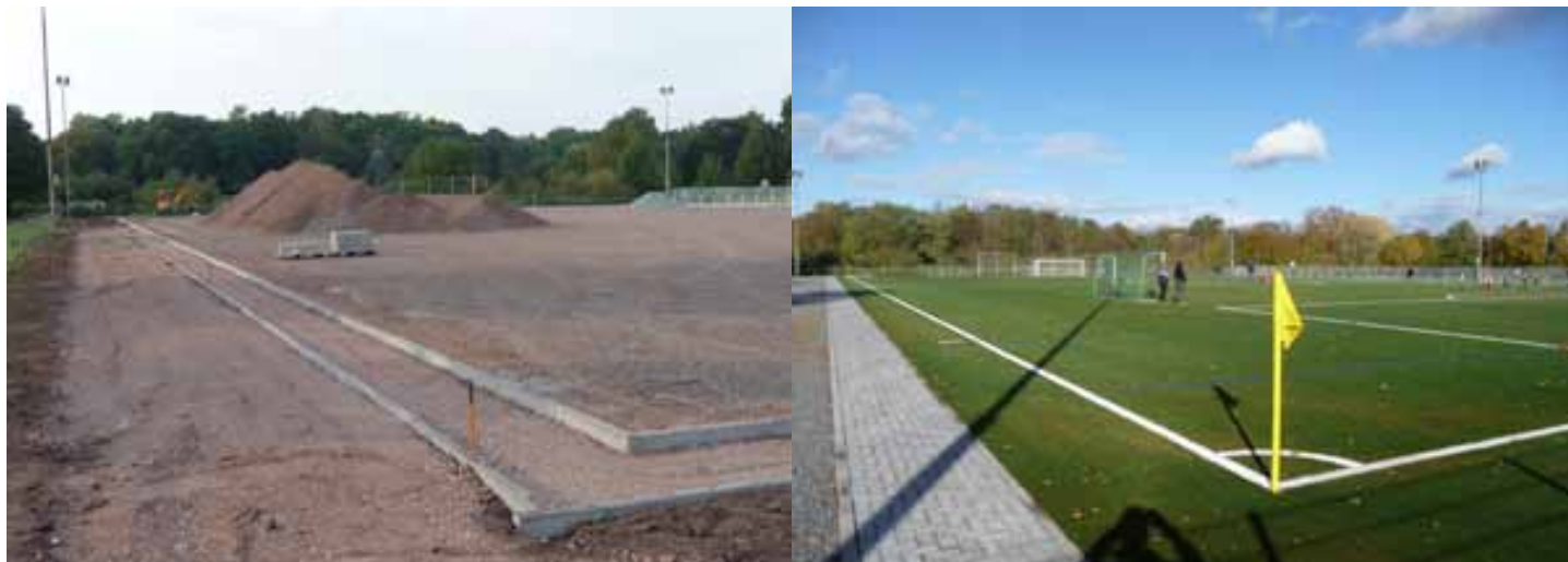
Sechs Wochen liegen zwischen diesen beiden Fotos. Seit dem 5. November können die Fußballmannschaften des TV Crumstadt den neuen Kunstrasenplatz auf dem Crumstädter Sportgelände für ihren Sportbetrieb nutzen. Fotos: Gernot Hofmann
